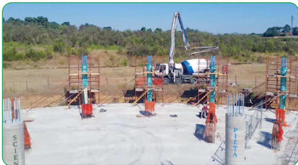
Le altre 4 colonne in fase di completamento
