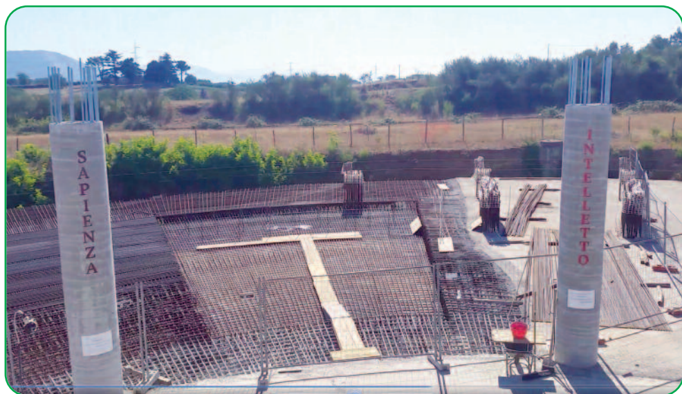
Parte della piattaforma ancora da cementare
